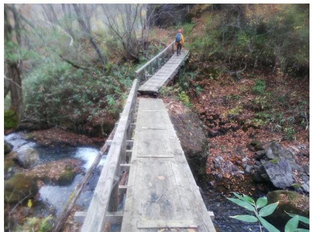
仏沢の橋を渡り完了
